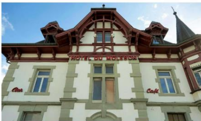
Longtemps délaissé, le chantier de l'ancien hôtel-restaurant du Moléson a repris de plus belle. Charly Rappo
